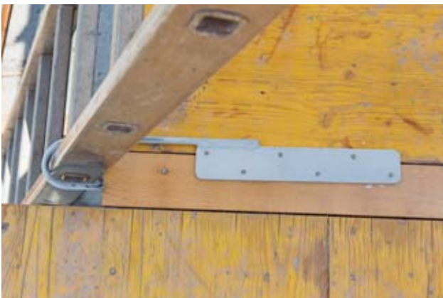
Bild 26: Sichern des Leiterkopfes mit Haken
