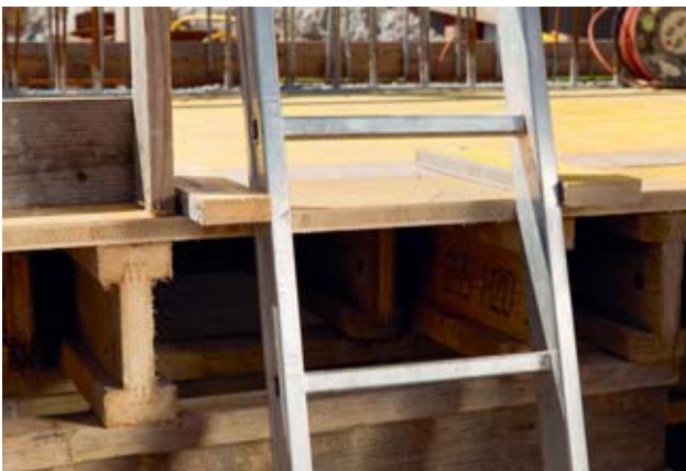
Bild 24: Seitliche Führung des Leiterkopfes
