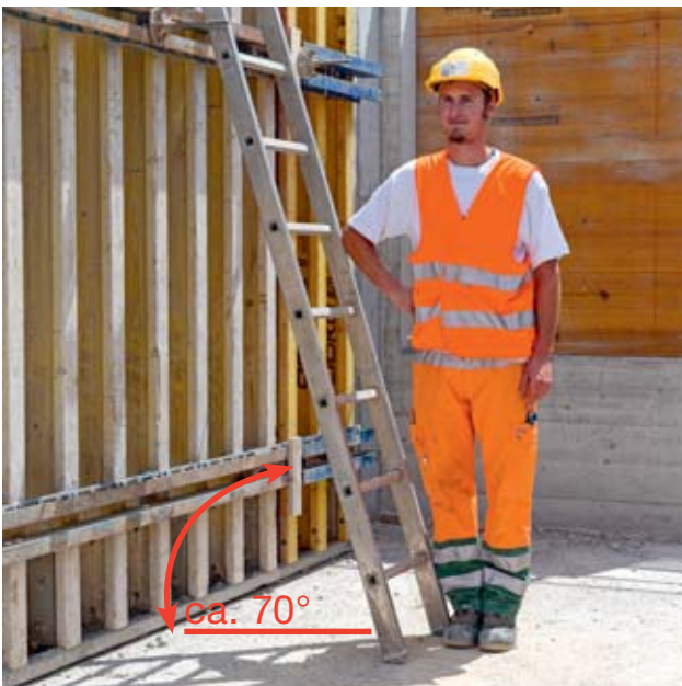
Bild 17: Überprüfen des Anstellwinkels mit Ellbogenprobe
