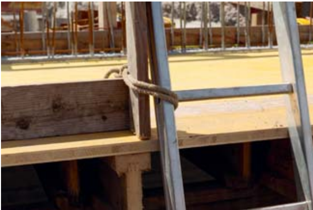
Bild 25: Mit Seil befestigt
