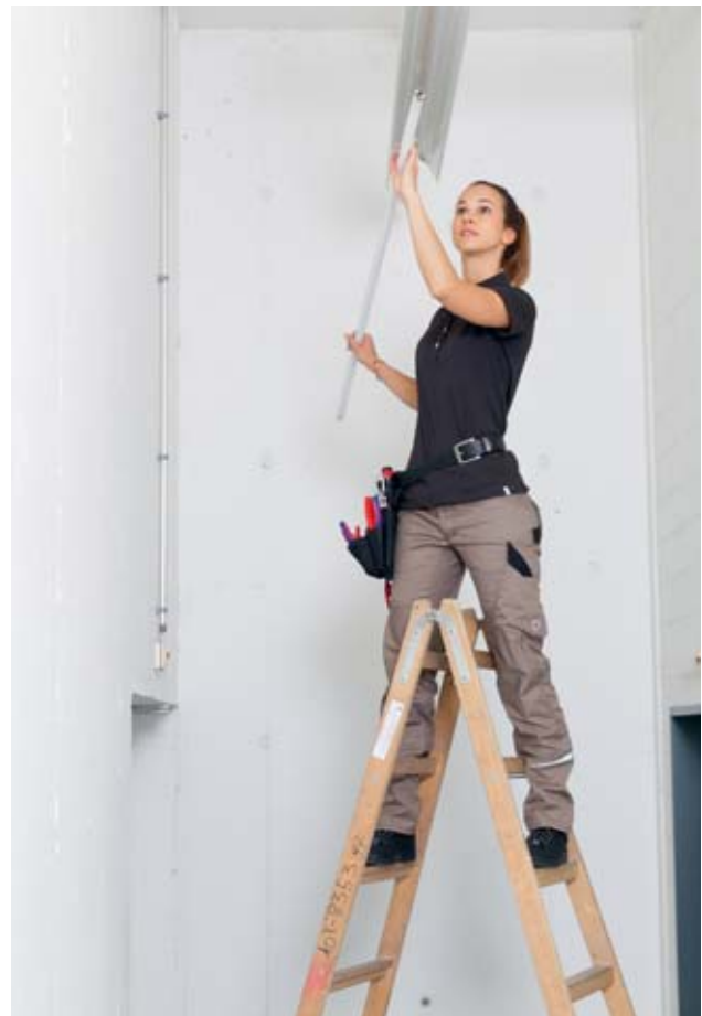
Bild 42: Beim Stehen auf der drittobersten Sprosse bieten die obersten zwei Sprossen den notwendigen Halt.
