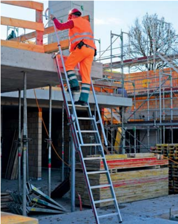
Bild 16: Verlängerte Leiterholme für den sicheren Überstieg
