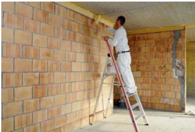
Bild 47: Stufenbockleiter mit Plattform und Haltevorrichtung
