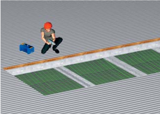
Bild 20 Auffangnetz bei Öffnung für ein Oblicht
