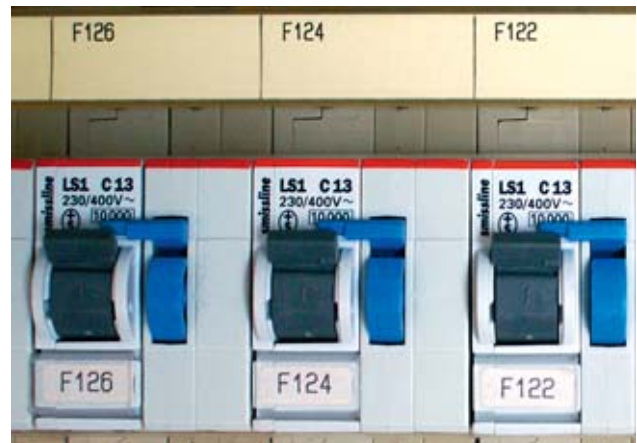
Bild 11: Leitungsschutzschalter
