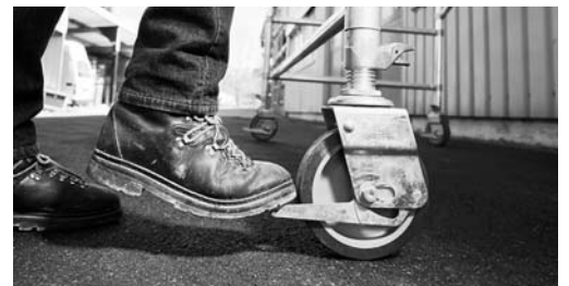
Bild 4: Vor dem Besteigen wird die Rollen-Bremse arretiert.
