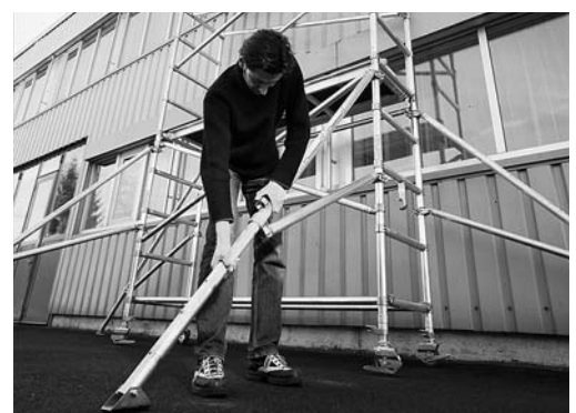
Bild 3: Sicherung des Rollgerüsts gegen Kippen.
